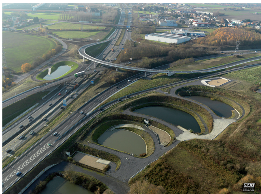
L'échangeur entre l'A2 et l'A23 dans le Valenciennois
