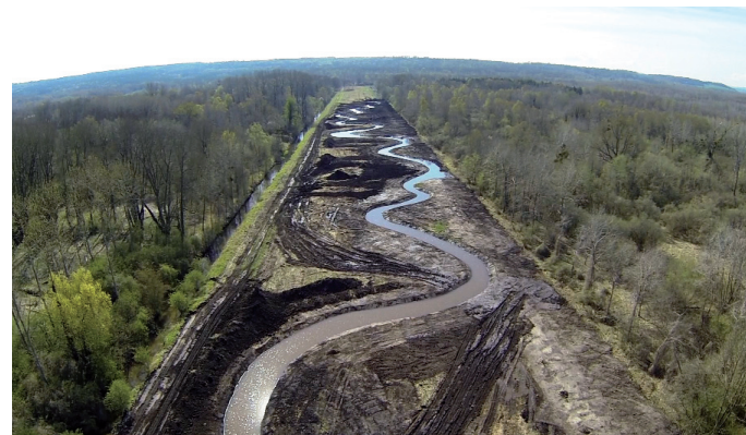
Réméandrement de la TRYE : avant et après les travaux
